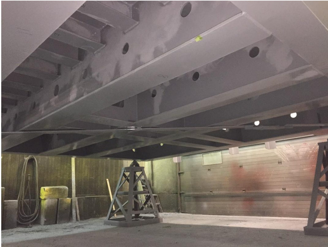
Sablage des portes de l'écluse de Black Rapids
